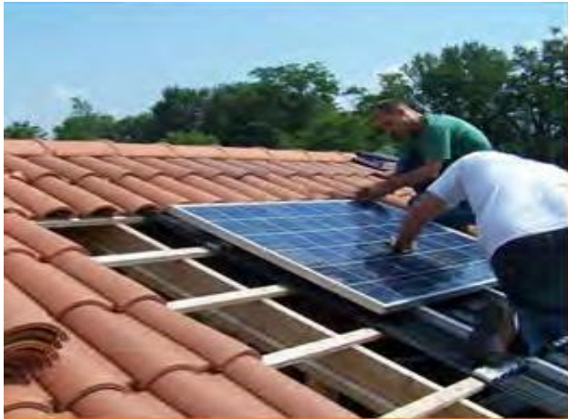
Pose en toiture
